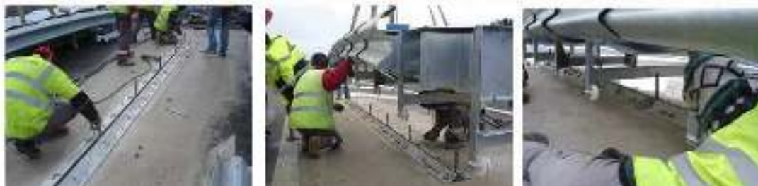
Obrázek 16 - Postup montáže na monolitickou základovou desku
