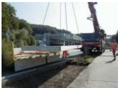
Obrázek 9 - Osazení tlumiče s betonovým prefabrikátem
