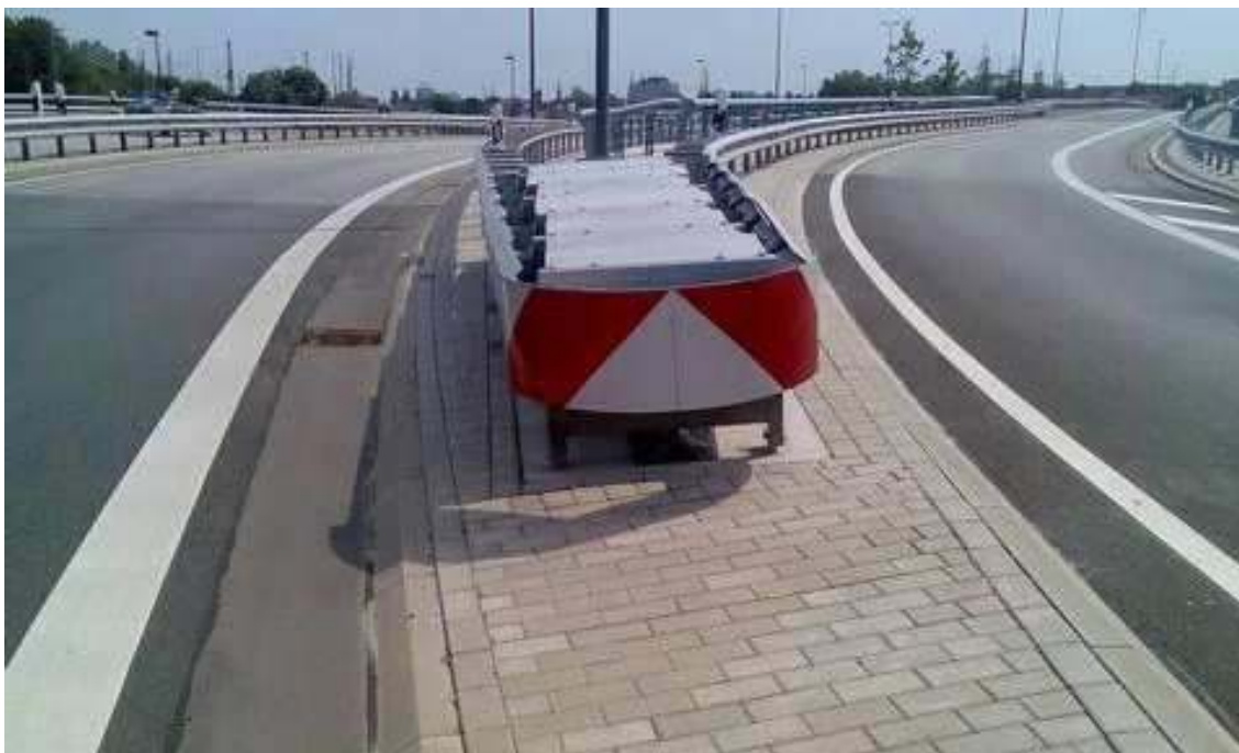
Obrázek 6 - Montáž v příčném sklonu
