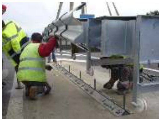
Obrázek 14 - Montáž vlastního tlumiče na betonovou základovou desku
