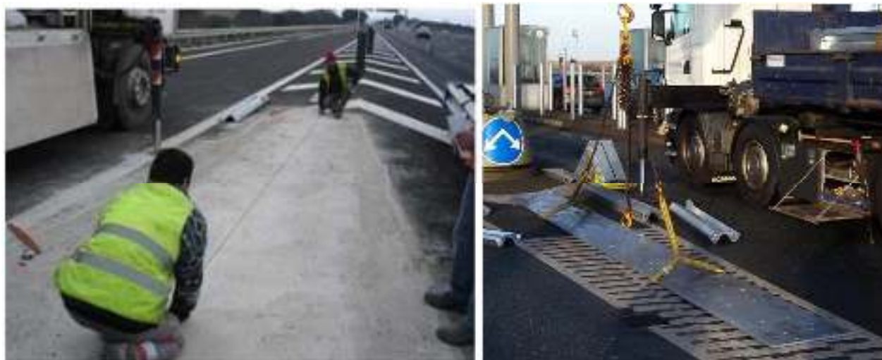
Obrázek 8 - Ocelová deska montovaná na AB a CB povrh
