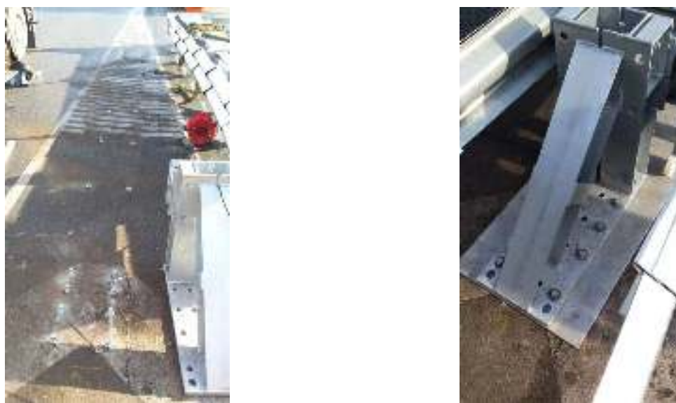
Obrázek 17 – Montáž tlumiče na ocelovou desku – rozmístění chemických kotev
