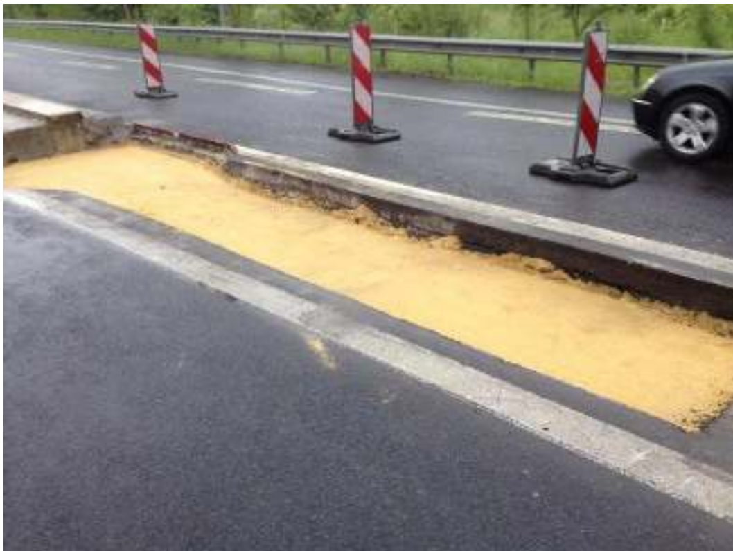
Obrázek 7 - Vyrovnání plochy ložem z těžného písku
